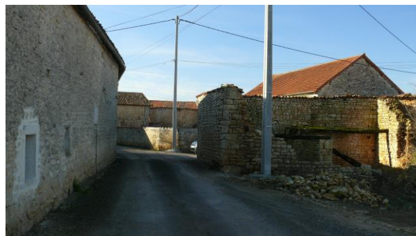
Le village des Loges : des possibilités de rénovation qui subsistent
