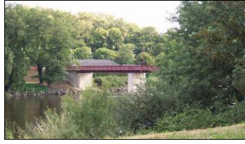
4. – Les paysages de la vallée de la Vienne : Vues de proximité le long de la Vienne
