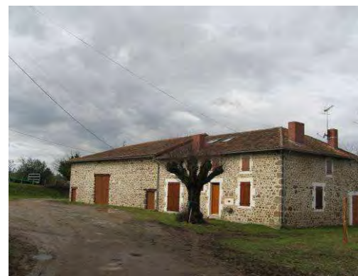
Ferme isolée : prolongement de l'habitation par les dépendances – L'Aubicherie
