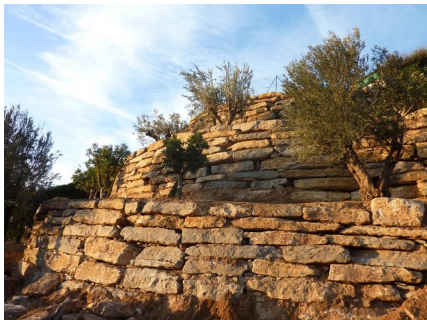
Blocs taillés de manière rectangulaire et intercalation de terrasses végétalisées (source : gtp-saintemaxime.com)
