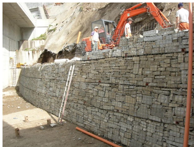
Mur en gabions (source : granitimaurino.ch)
