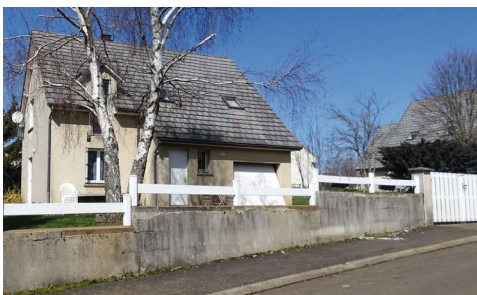
Éléments positifs : forme simple et massive de la maison, châssis et lucarne participant à l'équilibre de la façade, accès implanté face au garage Éléments négatifs lié au mauvais vieillissement des matériaux : couleur de toiture qui se délave et clôture en ciment qui coule et se désagrège
