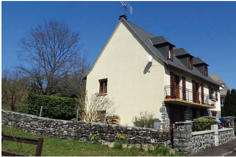
Construction de forme simple et massive bien intégrée dans son site et clôture en pierre de pays
