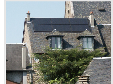
Panneaux photovoltaïques adaptés aux toitures en ardoise (Vigeois, 19) : structure photovoltaïque noir non réfléchissante et cadre noir.
