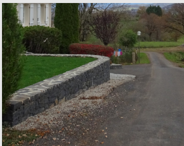
Exemples de clôtures adaptées (Jaleyrac) : haie basse taillée, muret surmonté d'une haie vive diversifiée, mur de soutènement en pierre de pays.
