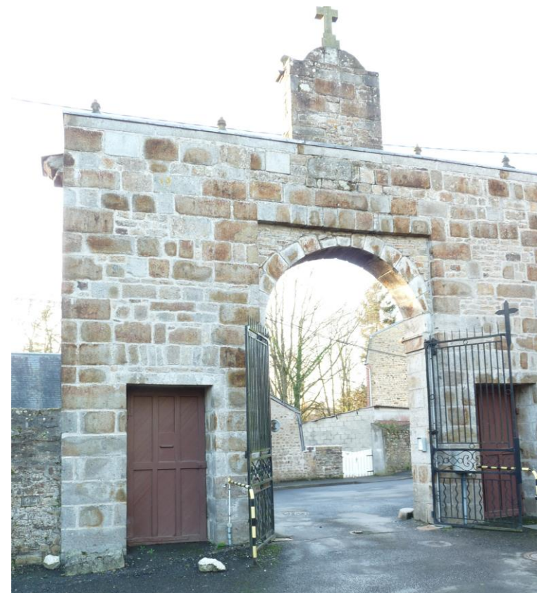
Portail – vue côté cour
