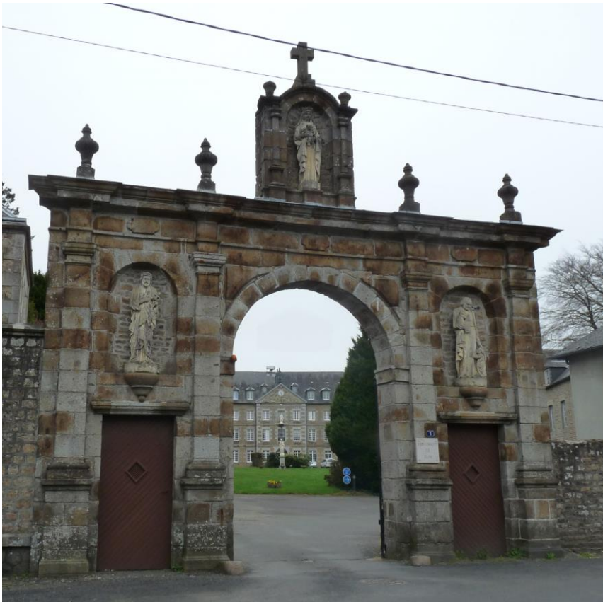
Portail – vue côté rue
