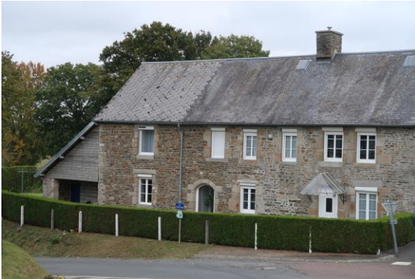
Le bâti ancien
