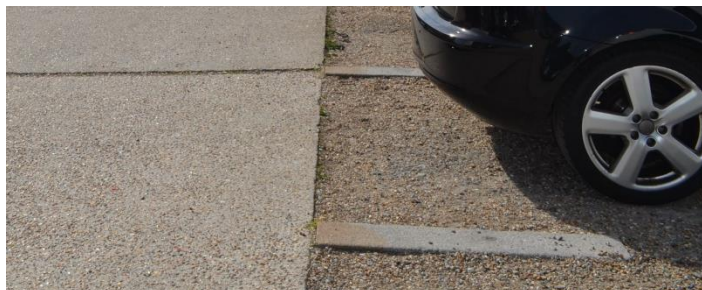
Exemple d'espace de stationnement perméable en graviers accompagné d'une circulation en béton désactivé
