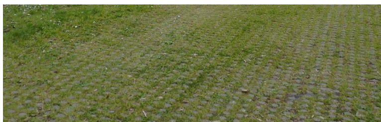
Exemples de revêtements perméables et plantés
