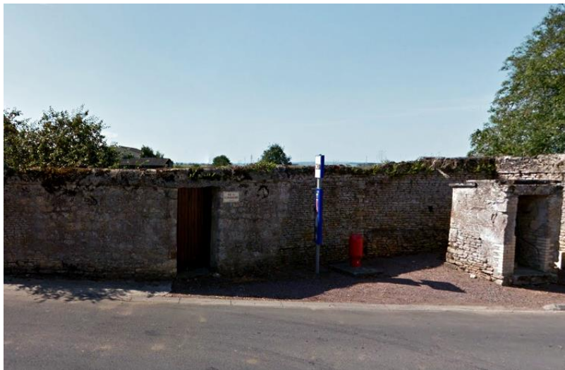
Accès piéton existant depuis la rue des Glengarrians
