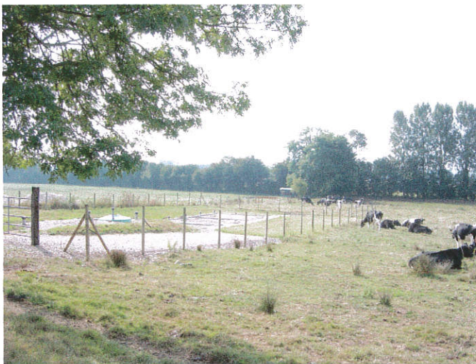
Station d'épuration locale du hameau de Torp
