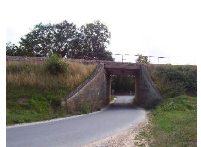
Virage après le pont voie ferrée à Grisy
