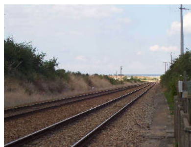
Voie ferrée depuis le passage à niveau de VENDEVRE
