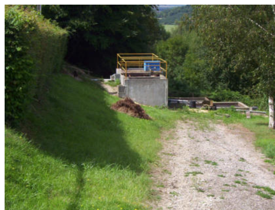
Station d'épuration du Billot
