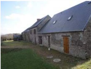
Toiture en ardoise du bâti traditionnel
