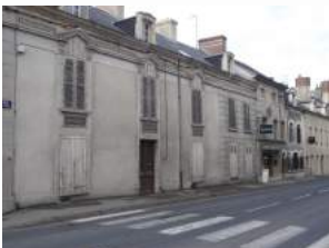
Lucarnes du bâti traditionnel
