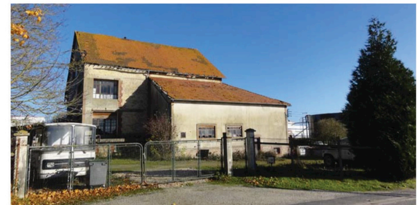
5. Chemin de sur les Portes - Bâtiment d'activités désaffecté
