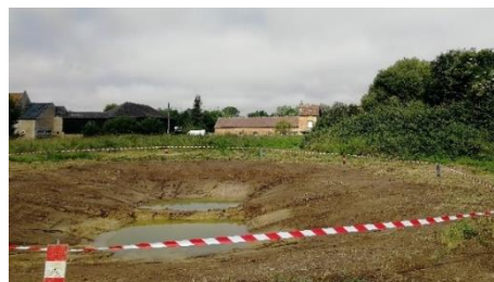
Fouille réalisée pour identifier le niveau de la nappe.
