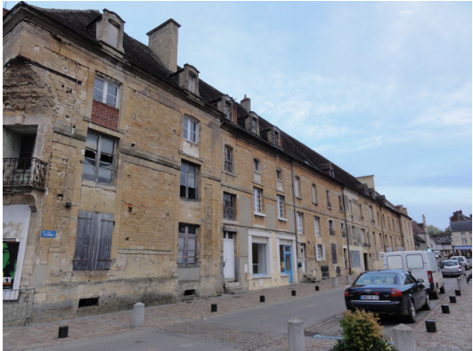
Bâtiments conventuels : Aile sud
