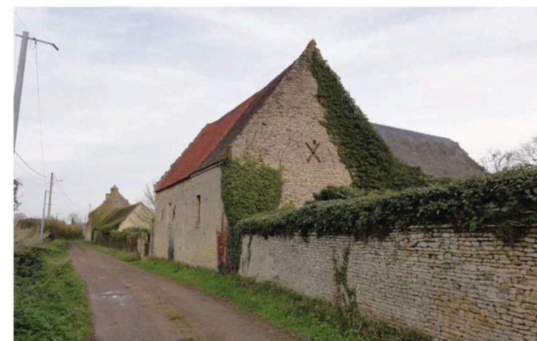
2. Route de Grisy, ancien corps de ferme en «U» entouré de murs en pierre
