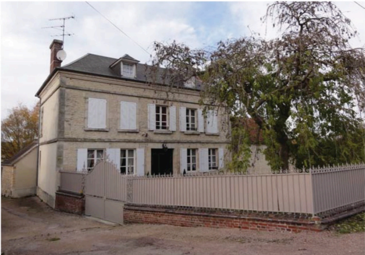
6. Maison de maître située le long de la RD 511
