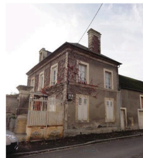
4. Route de Caen, Maison de maître
