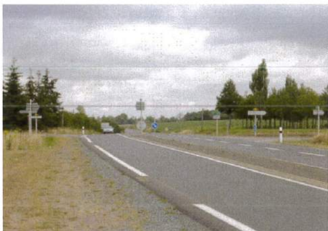
Le carrefour d'accès entre le centre bourg et la RD562 en venant de Flers
