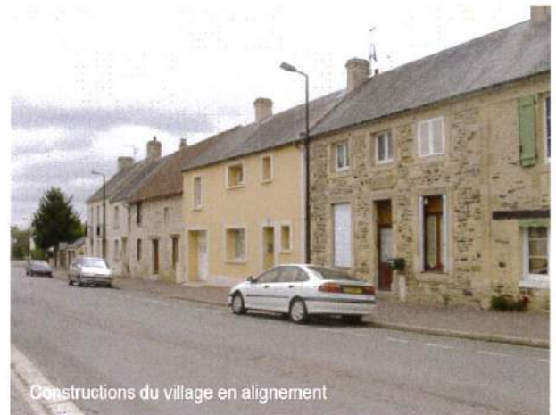
Les ouvertures plus étroites à l'étage témoignent de l'ancienneté des constructions
