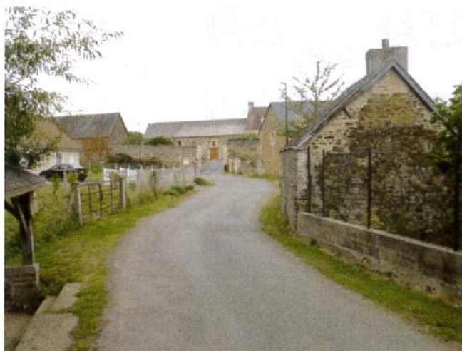
La traversée du Bas de Saint Laurent offre des vues sur le patrimoine bâti (maisons, lavoirs)
