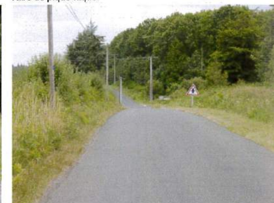
La RD 171, au carrefour de Boulon, est marquée par un léger dénivelé qui limite la visibilité
