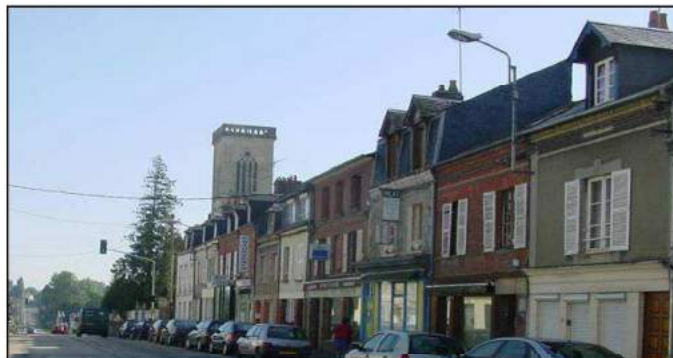
Les constructions en brique
