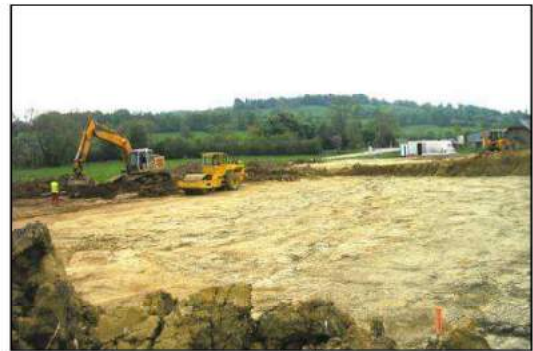
Gymnase en construction
