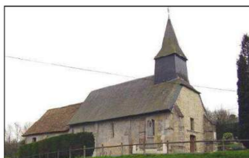
Eglise de Cresseville
