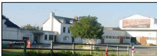
d'ancienne usine (cidrerie ; entrée de PUTÔT-EN-AUGE le long de la RD 675).
