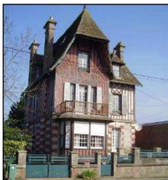
Les constructions en brique
