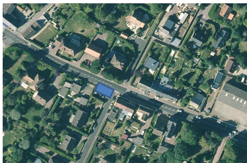
Fig. 40. Implantation du second bassin d'infiltration
