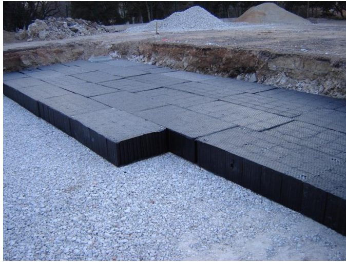
Fig. 36. Exemple de bassin enterré à casiers ©www.nidaplast.com
