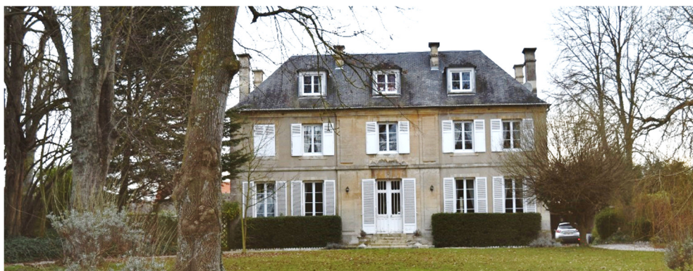
Maison de maître, située au Sud-Est du bourg, dans un parc arboré
