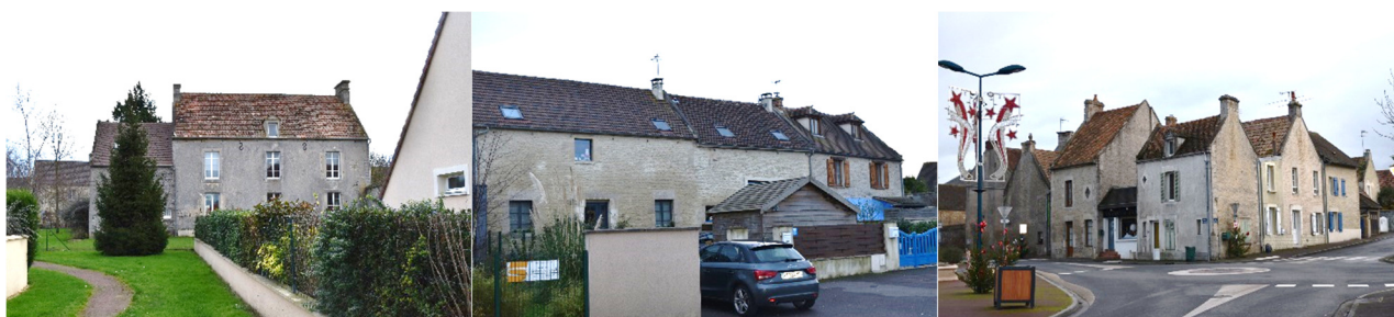
Constructions composées d'un rez-de-chaussée, d'un étage et d'un comble.
