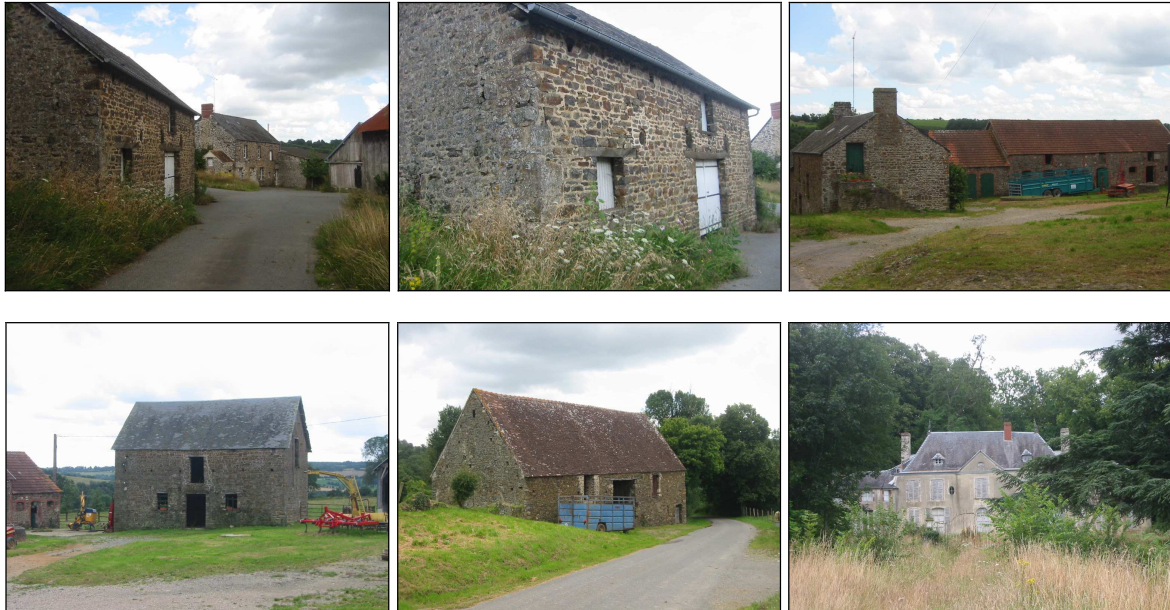
Photos n°37, 38, 39, 40, 41 et 42 : Abandon et manque d'entretien du bâti ancien traditionnel
