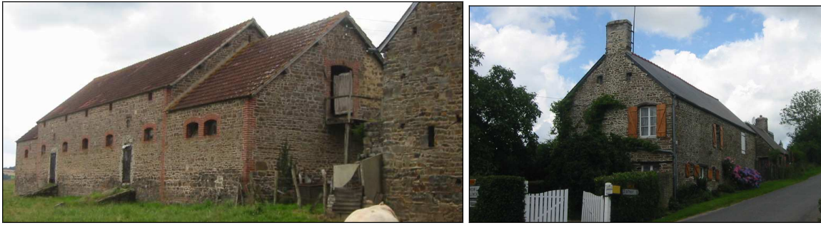
Photos n°45 et 46 : L'utilisation du schiste, et ponctuellement de la brique en façade.
