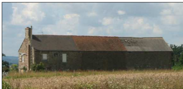
Photo n°44 : Maison traditionnelle située au sein du lieu dit Les Quesnets
