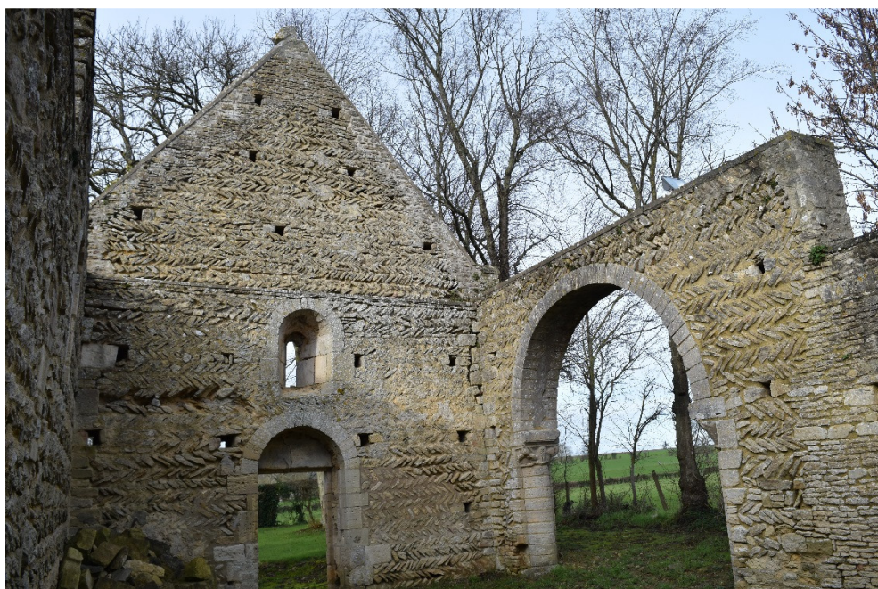
La nef de l'Eglise, à ciel ouvert et ses murs, construits en arêtes de poissons
