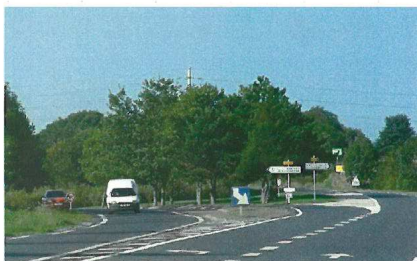
Terre-plein à l'intersection des RD 400 et 400a
