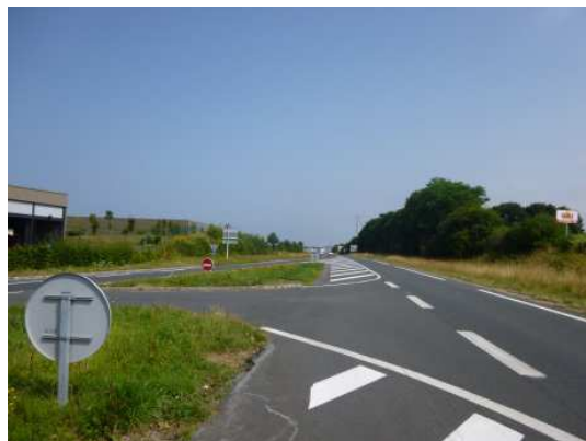
Aménagement RD 400 / RD 400a
