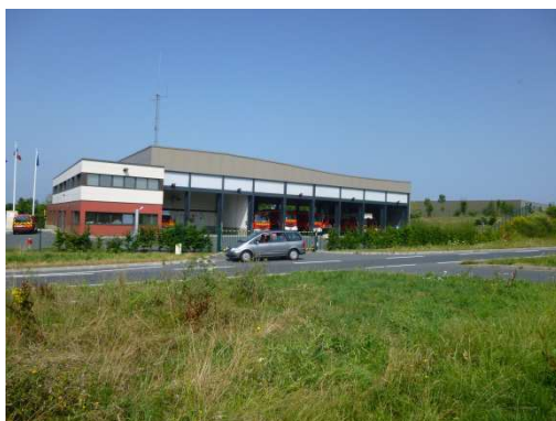
Caserne des pompiers
