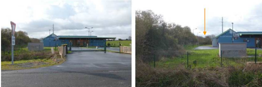
La salle polyvalente « Nelson Mandela »: un espace suffisant (10 mètres environ) pour créer un accès au site sans créer de conflits d'usage ?
