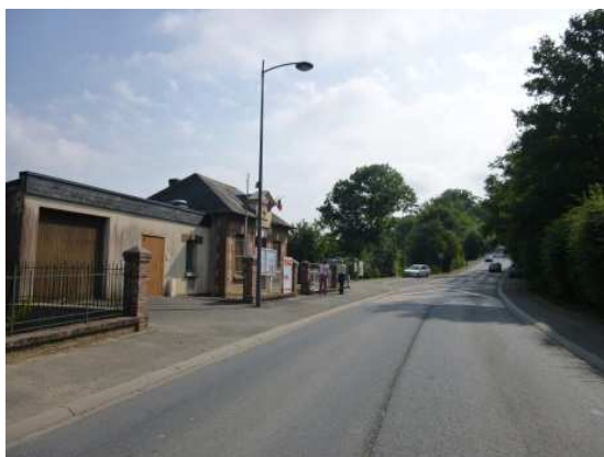
Traversée de la Poste : Aménagements
