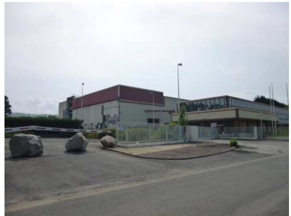
Entreprise en friche : Potentiel de renouvellement urbain
