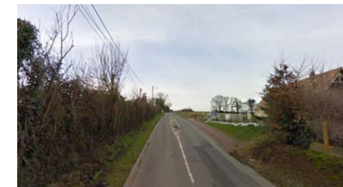
Vue sur la RD212 en direction Trois-Monts
