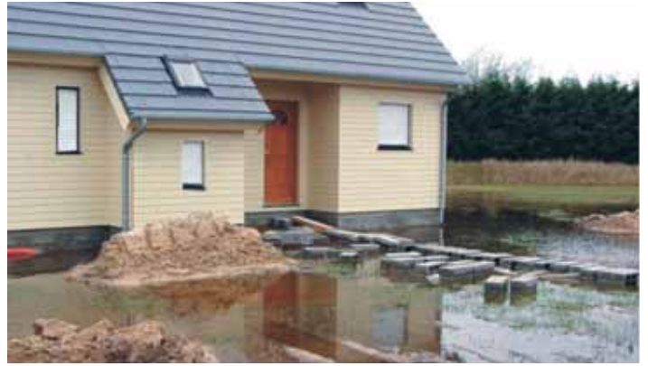
Construction neuve à Saint-Georges-la-Rivière (Manche) - CIDIREN
