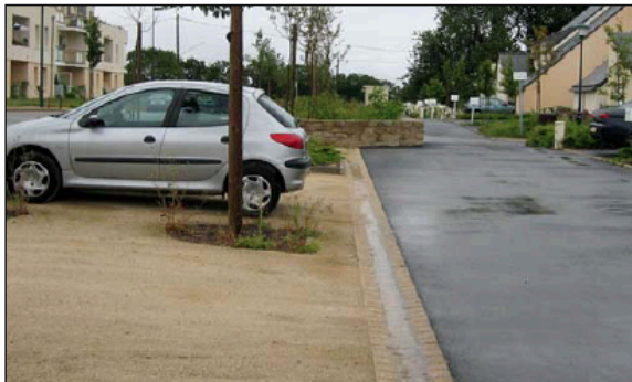
Caniveau et stationnement sur sablé
