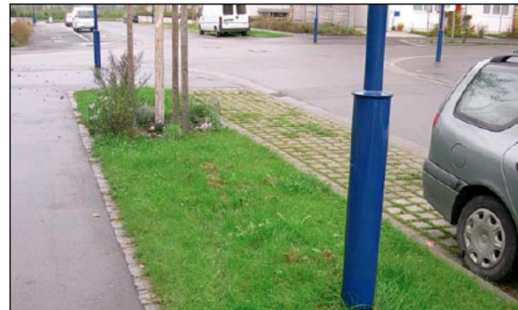
Stationnement sur dalle gazon et enherbement pouvant dissimuler une tranchée drainante
