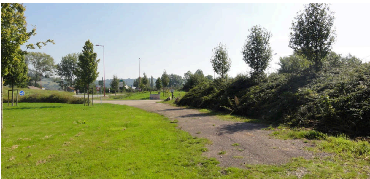
Vue vers l'est depuis sur l'accès aménagé entre le giratoire et le chemin rural: on distingue l'accès à l'aire de stationnement après la haie large.
