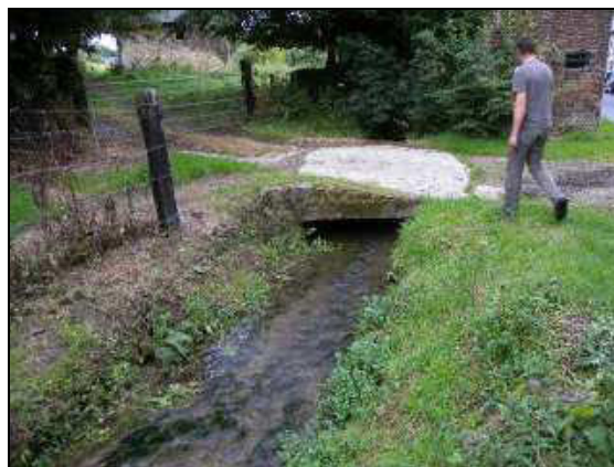
Figure 3-2 : chemin d'accès aux parcelles rive gauche, cadre OH1.
