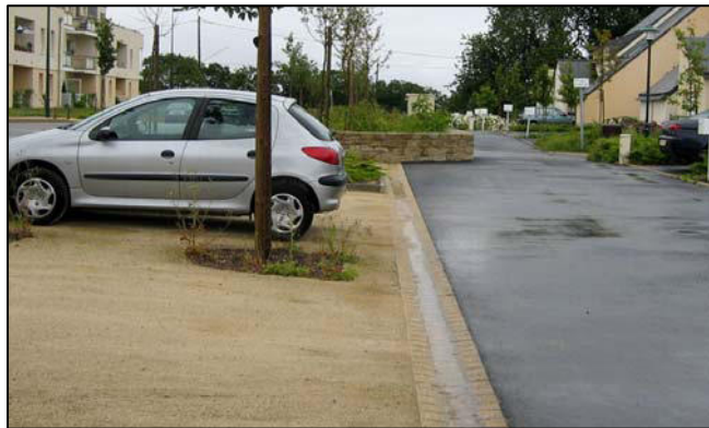
Caniveau et stationnement sur sable
