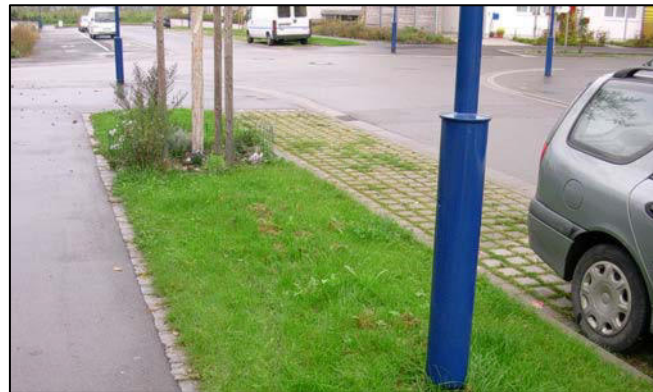
Stationnement sur dalle gazon et herbement pouvant dissimuler une tranchée drainante
