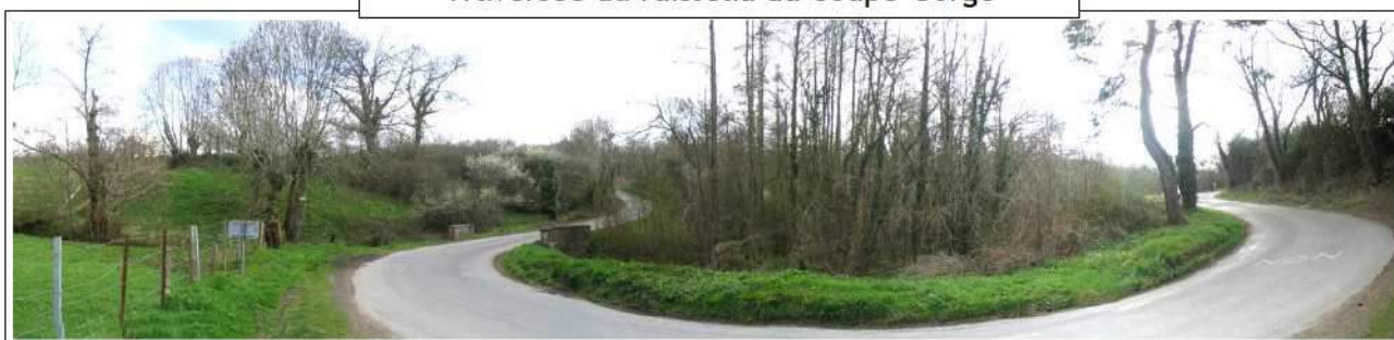
La RD 156 à la limite sud de la commune Traversée du ruisseau du Coupe-Gorge
