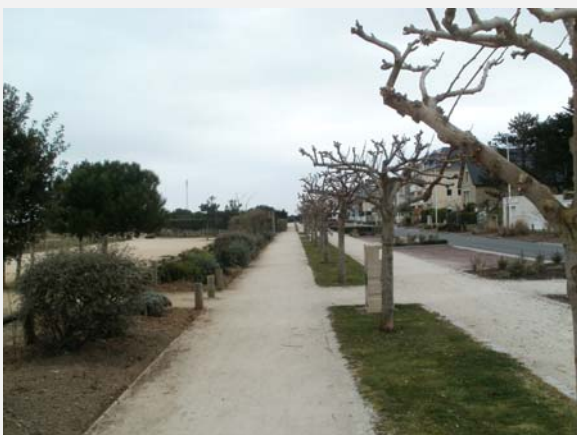
Aménagement d'un cheminement © TECAM
