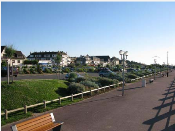
Aménagement d'une promenade en front de mer © TECAM
