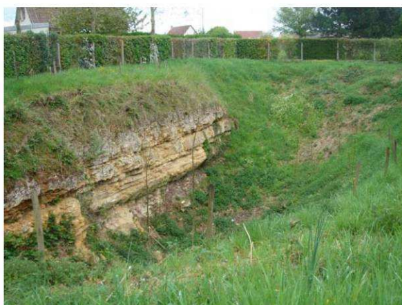
Vue générale depuis l'entrée du site (© F. et P. GIGOT)
