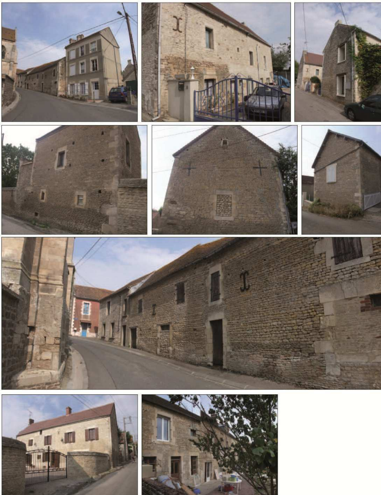
Exemples de façades du centre bourg ancien. Les façades sont principalement en calcaire, avec des pierres de taille en encadrement de baies, de portes, et en linteaux. On trouve sur plusieurs façades des tirants métalliques travaillés qui participent à la composition d'ensemble.
