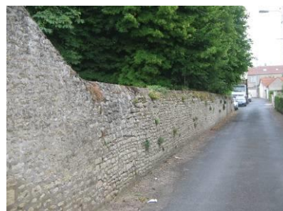
Mur Section AE- rue du Vivier
