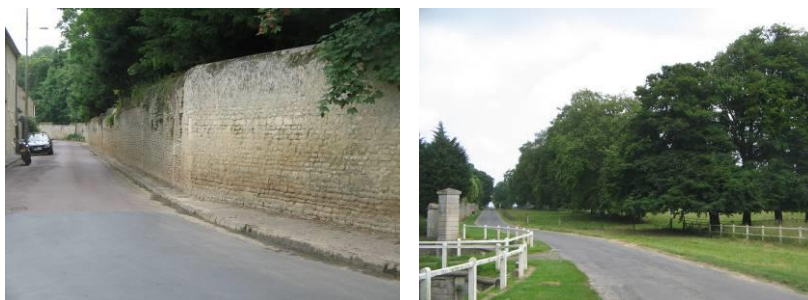
Murs du château Section AH – CD n°84 – rue de Luc sur Mer
