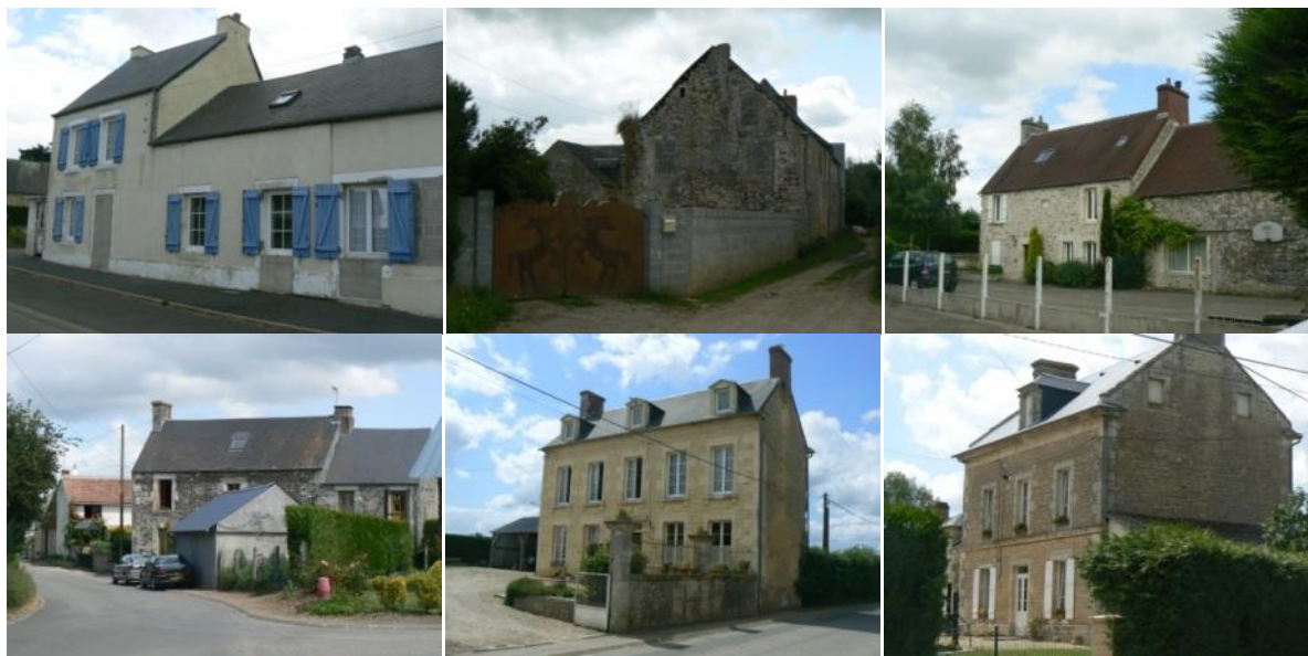
Photos n°25, 26, 27, 28, 29 et 30: Le bâti ancien à LEFFARD
