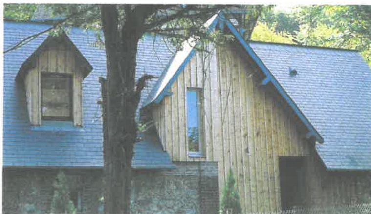
12 Restauration à Honfleur - architecte HEMON
