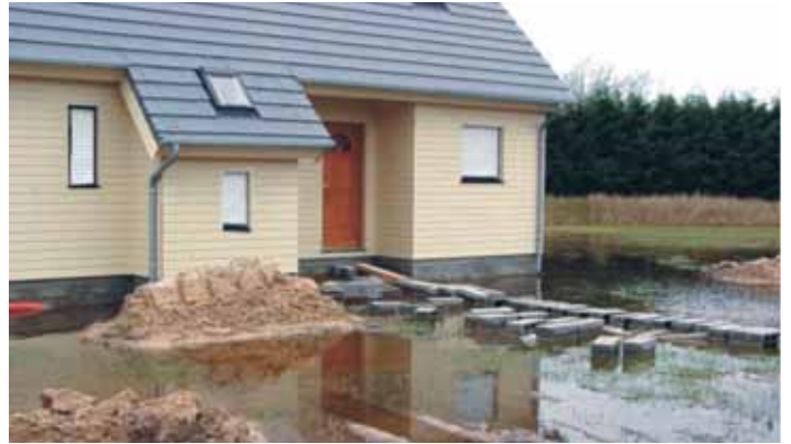
Construction neuve à Saint-Georges-la-Rivière (Manche) - CIDIREN
