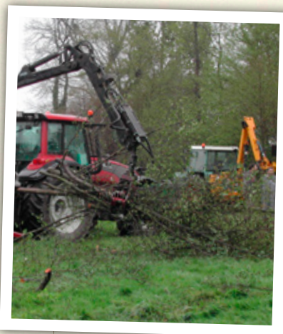
Déchetage des branches coupées.
