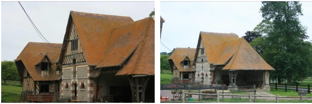
Façade du bâtiment 2
