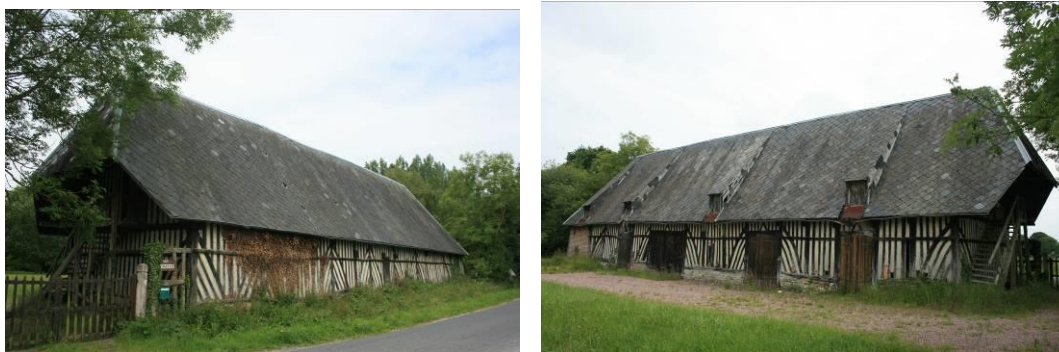
Façade arrière et avant
