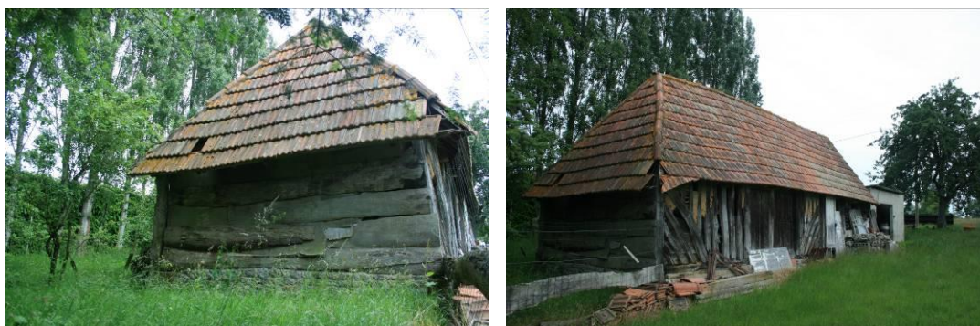
Pignon et façade avant
