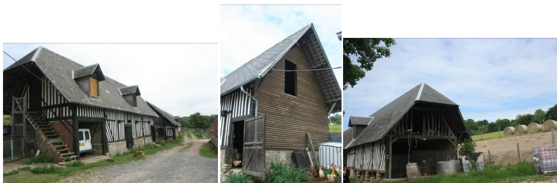
Façades et pignons du bâtiment 1 et pignon du bâtiment 2
