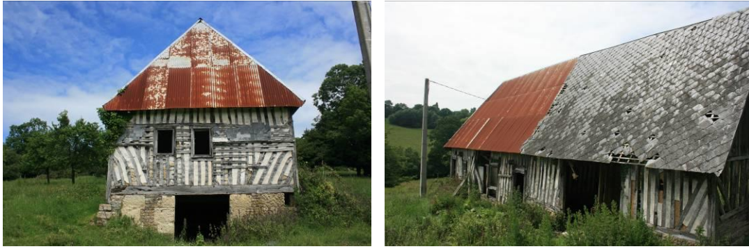
Façades et pignons du bâtiment isolé
