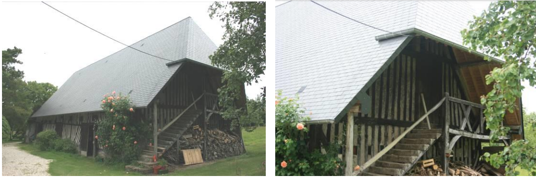
Façades avant et pignon du bâtiment 3
