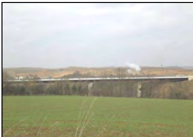
Pont routier enjambant la vallée de la Laize
