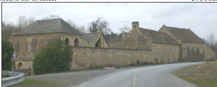
Les corps de ferme et les anciens bâtiments d'artisanat
