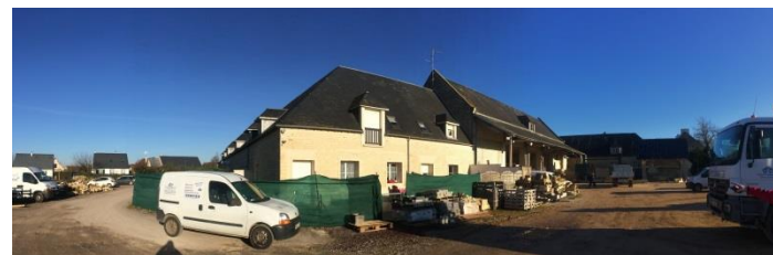
Logements groupés vus depuis la zone de stockage
