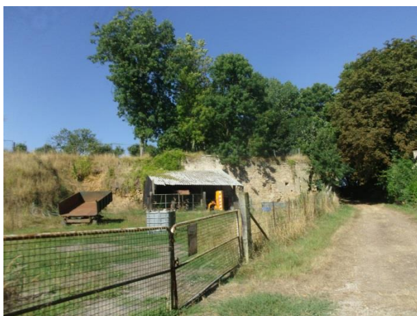
Bâti en pierres en ruine
