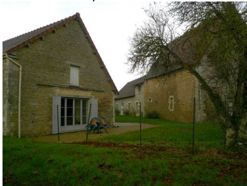
Bâtiments annexes situés au nord du Logis.
