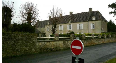
Façade ouest du bâtiment principal
