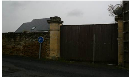
Mur de clôture et pile en pierre de Caen.
