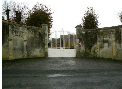
Portail, rue de l'Épine
