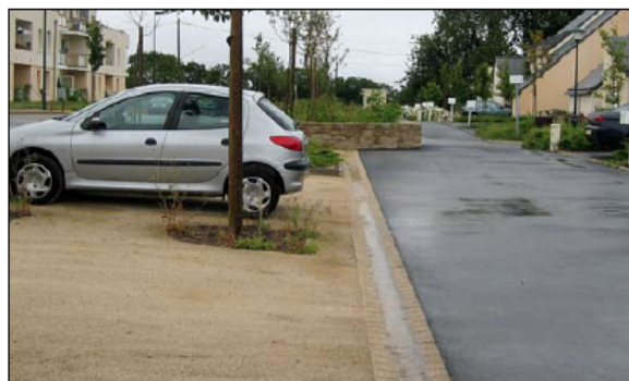
Caniveau et stationnement sur sablé
