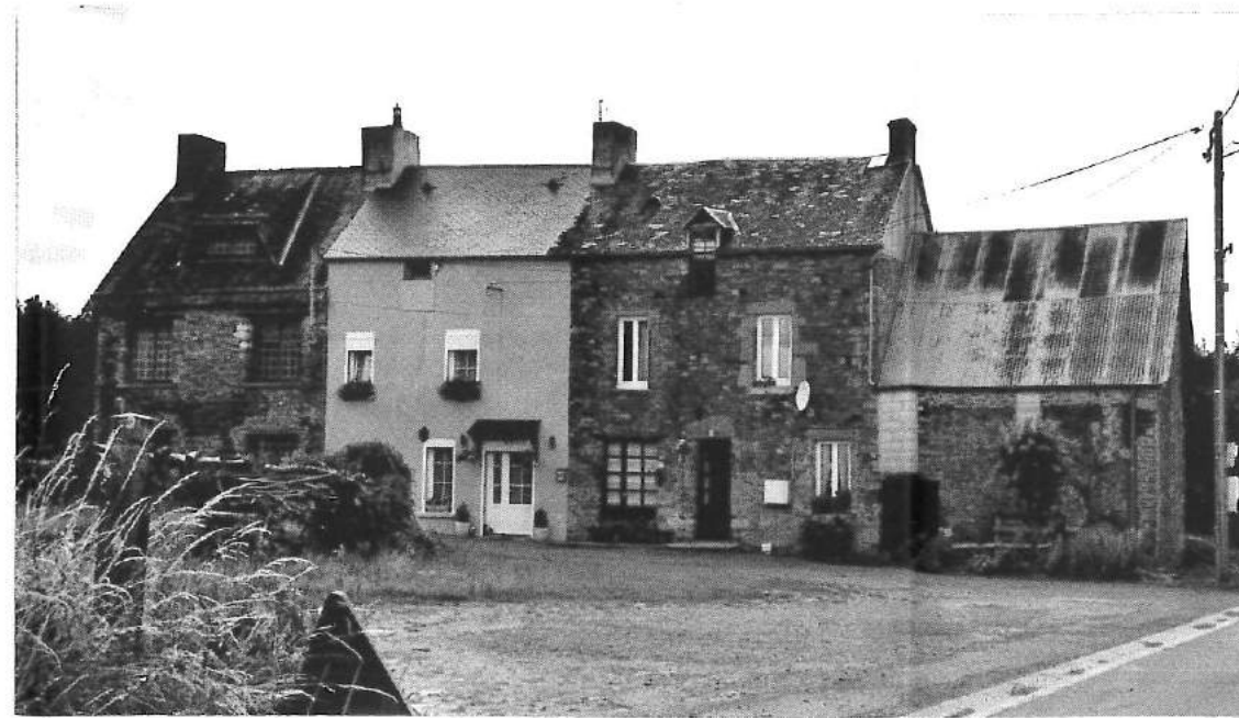
BÂTIMENTS ANCIENS -Insertion récente
