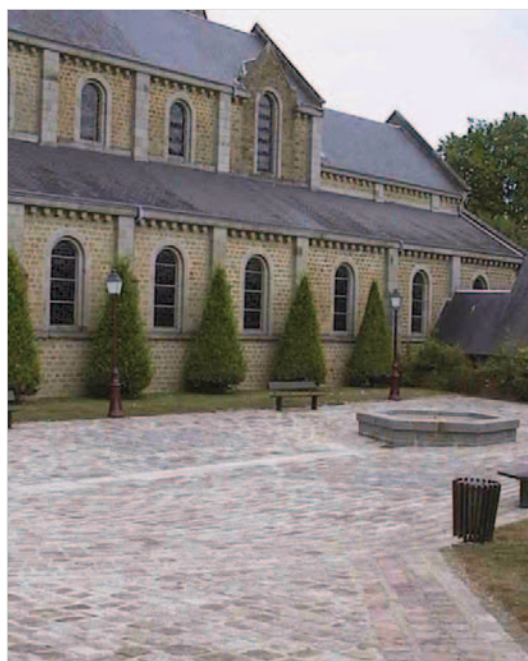
L'aménagement de la place de l'Eglise Saint-Martin
