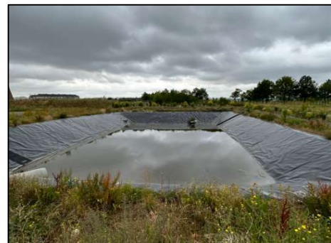
Figure 52 : Bassin de rétention sur le site 5 (Source : L'atelier de l'urbanisme)
