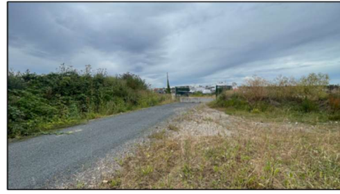
Figure 65 : Voie de circulation sur le site 6 (Source : L'atelier de l'urbanisme)
