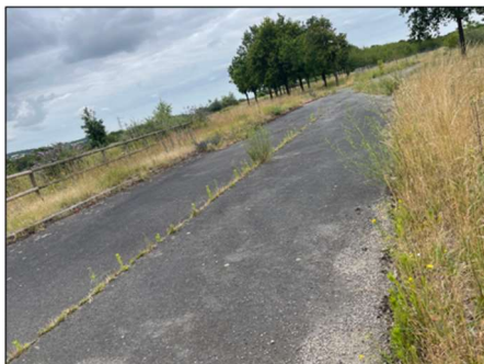
Figure 46 : Dalle béton sur le site 4
