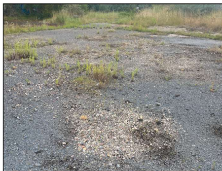
Figure 71 : Surface artificialisée sur le site 7 (Source : L'atelier de l'urbanisme)
