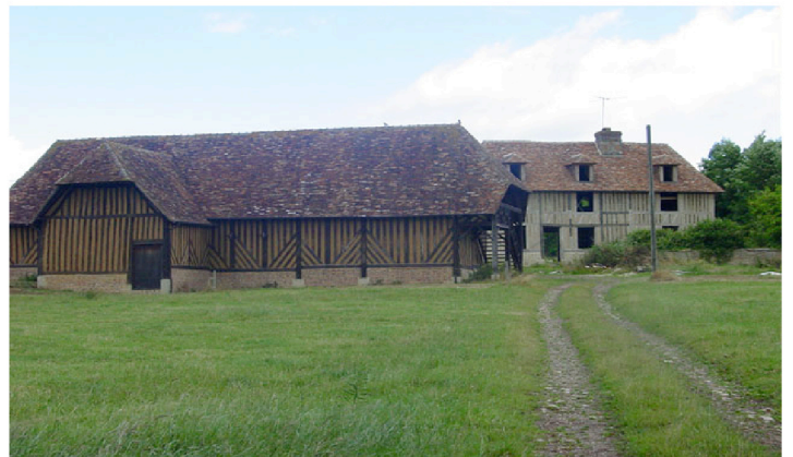
RÉHABILITATION D'UNE FERME
