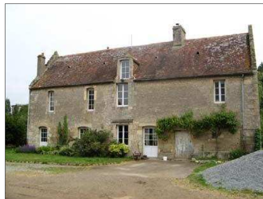
Logis de la ferme du bourg. Notons que les ouvertures ne respectent pas l'implantation traditionnelle.
