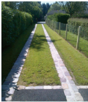
Exemple de bandes de roulement en pavés
