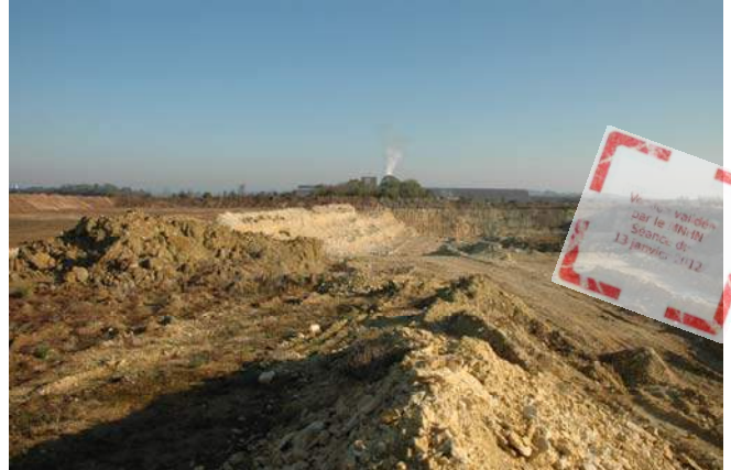
Vue d'ensemble sur la carrière Nord (© J. AVOINE)
