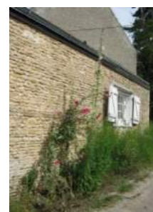
Maison de pierre (Navarre)
