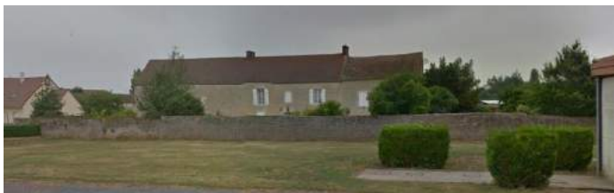
Un mur en pierre à côté de la salle des fêtes (parcelle : ZE 2)
