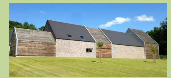
➤ Construction neuve d'un équipement , Station d'eau potable, Roullours (14), Agence Dauchez, CAUE (14)
