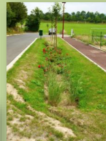
Noues Végétalisées (espaces verts en creux pour collecter les eaux pluviales)
