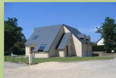
Volumes complexes avec de nombreux décrochés favorables aux ponts thermiques, il faut privilégier les volumes simples
