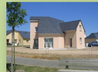
Volumes complexes avec de nombreux décrochés favorables aux ponts thermiques, il faut privilégier les volumes simples
