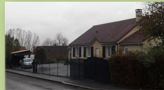
Une parcelle fortement imperméabilisée qui peut générer un volume important d'eau pluviale à prendre en charge.
