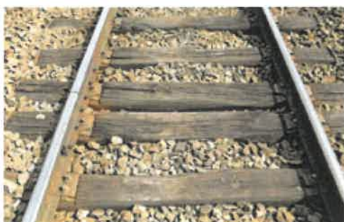
Rails courts sur traverses bois
