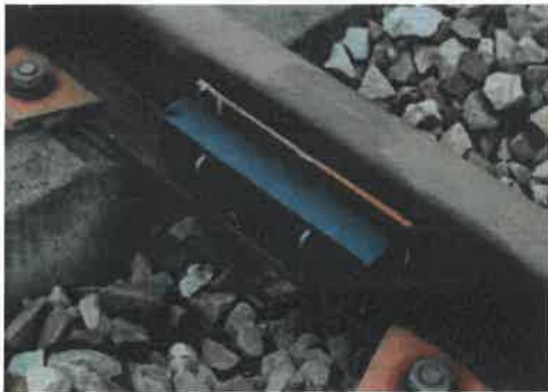
Exemples d'absorbeurs sur rail (Corus et Socitec)
