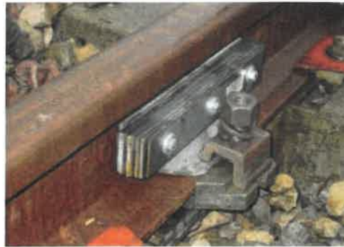
Exemples d'absorbeurs sur rail (Corus et Socitec)
