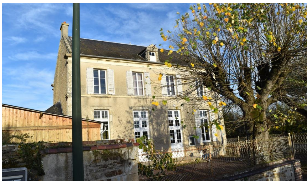
La maison des Tilleuls qui abritait l'ancienne école et la mairie
