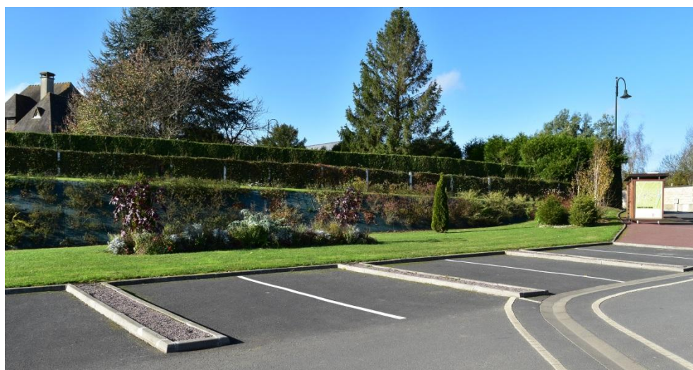
Aménagements de la Place de la Mairie
