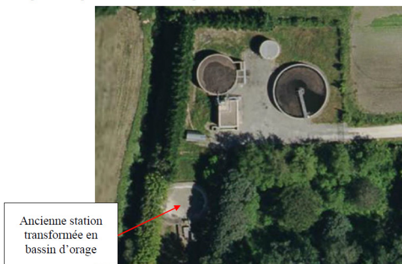
Vue aérienne de la station d'épuration
